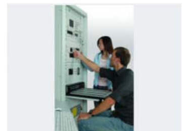
Trotz aller Standardisierung müssen im elektrischen Funktionstest häufig Sonderfunktionen in die Systeme integriert werden, was sich aber leicht bewerkstelligen lässt. (Bild: LX Instruments)
